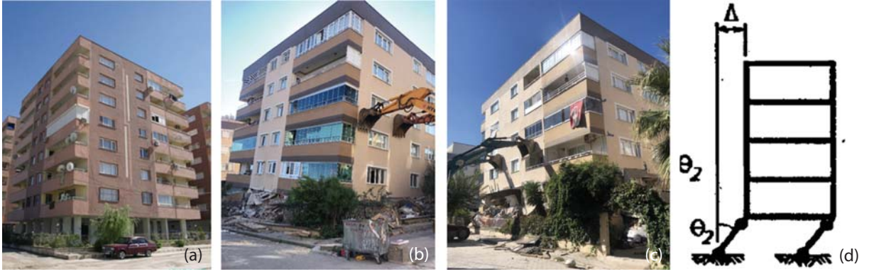
Şekil 11 - a) Zemin katında dolgu duvarları bulunmayan betonarme bina (2007) [6], b-c) Depremde zemin ve 1. Katı çöken betonarme bina, c) Yumuşak kat mekanizmasının oluşumu [7]
