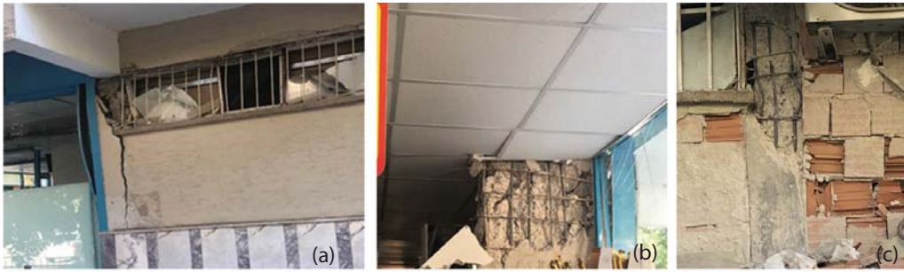
Şekil 11 - a) Zemin katında dolgu duvarları bulunmayan betonarme bina (2007) [6], b-c) Depremde zemin ve 1. Katı çöken betonarme bina, c) Yumuşak kat mekanizmasının oluşumu [7]
