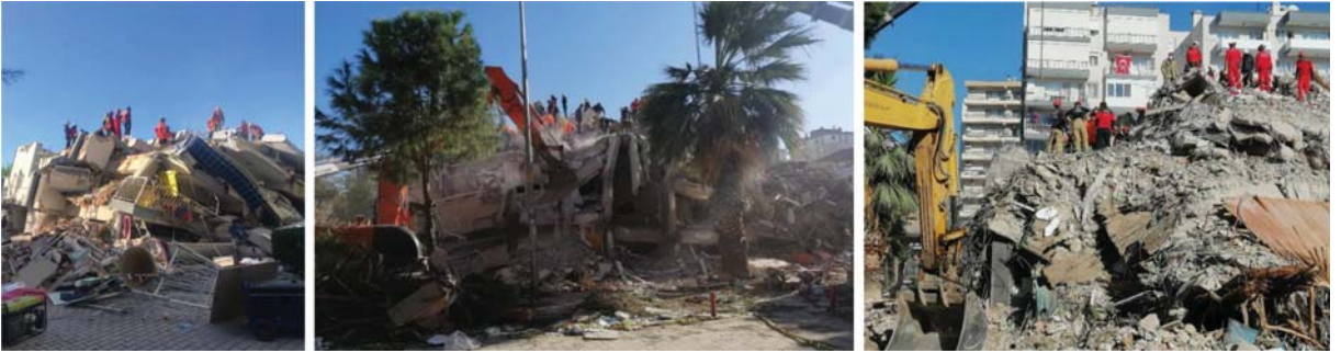
Şekil 3 - Sandviç tipi göçen yapılardan bazıları
